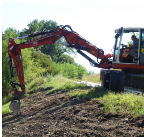
Oberbodenabtrag bei Staubing
