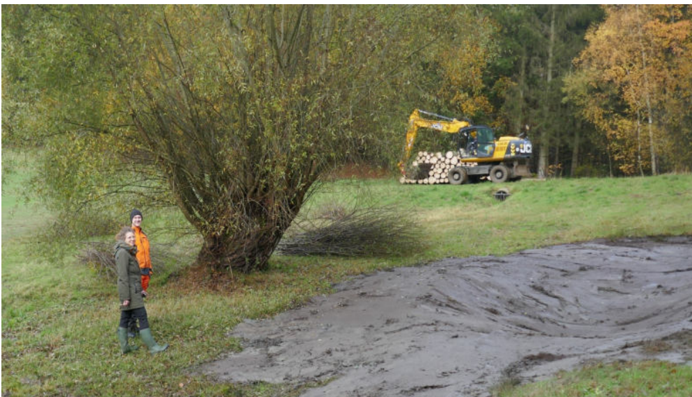
Anlage einer Vernässungsstelle für Amphibien bei Sandelzhäusern
