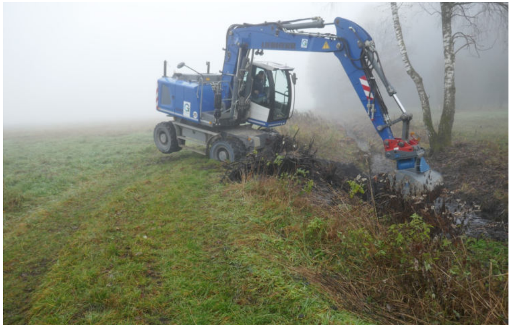
Beginn der Grabenumgestaltung
